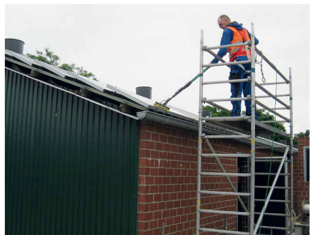
Bild 4: Das Solarreinigungsunternehmen beim Reinigen mit einem Gerüst innerhalb der Prüfung
