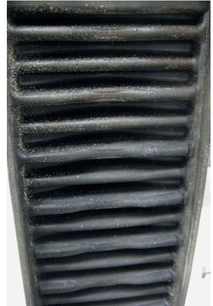
Bild 3: Unterseite der Auftrittsfläche
