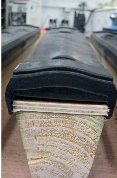
Bild 2: Auftrittsfläche mit integriertem Gefälle
