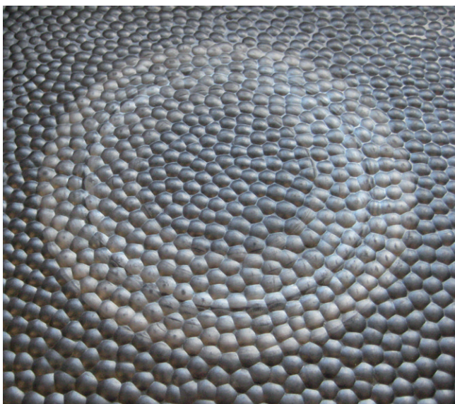
Bild 4: Oberseite Bodenbelag – nach der Dauertrittbelastung
