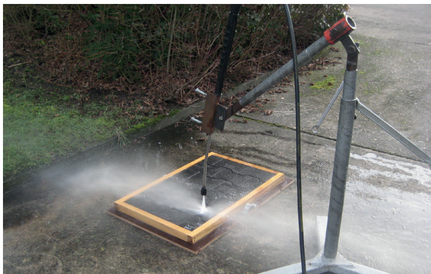
Bild 9: Messung der Reinigungsabstände mit Flachstrahldüse
