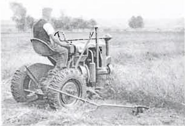
Mohlbalken mit Antrieb über Zapfwelle mit Ratschkupplung, sehr leicht abnehmbar, mit automa-
