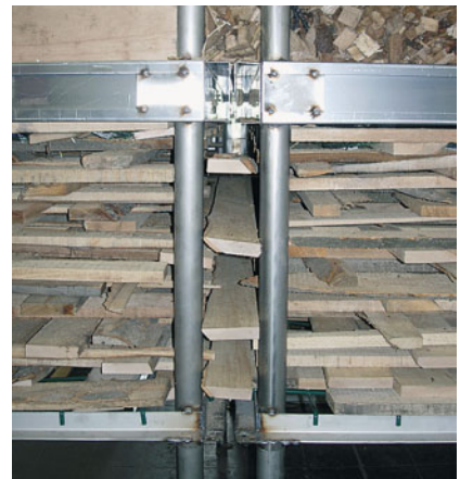
Bild 3: Abdichtung der Zwischenräume bei einander angrenzenden Modulen
